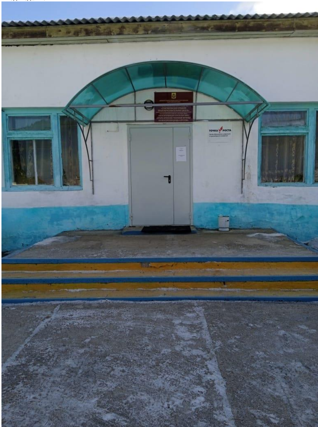
Фото № 2 Вход в здание
